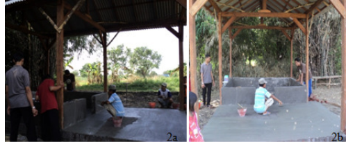
Gambar 2. Pembangunan bak pengomposan di lokasi terlindungi dari cahaya matahari langsung (2a). Finishing dan pengecekan pembangunan bak pengomposan dengan penghalusan bidang lantai (2b)
