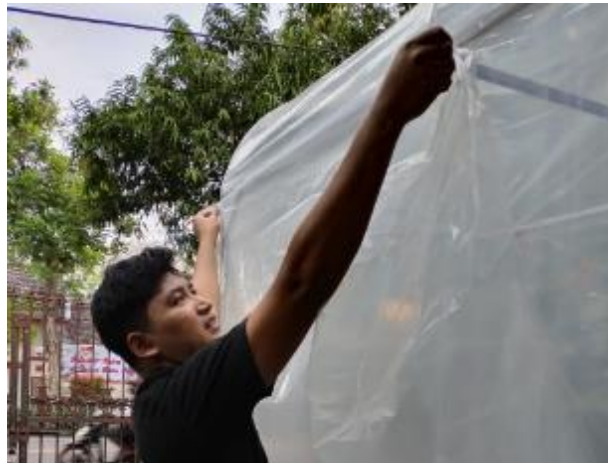
Gambar 8: Proses Pemasangan Dinding Menggunakan Plastik Transparan Pada Bilik
