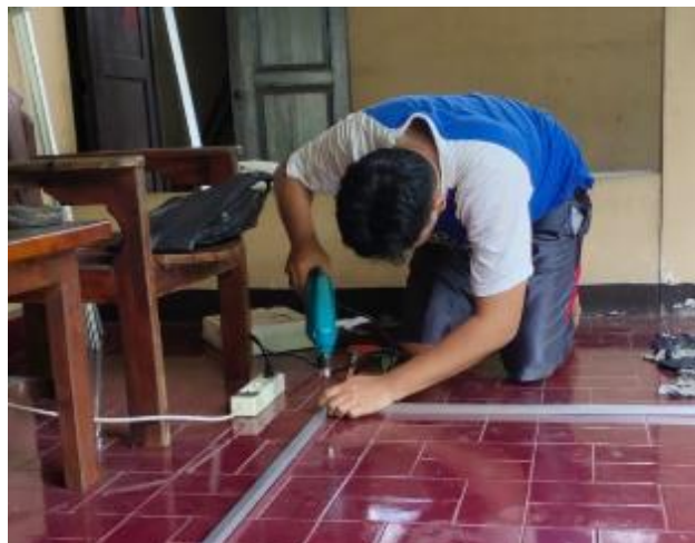
Gambar 6: Proses Pengeboran Pada Masing-Masing Sudut Rangka Aluminium
