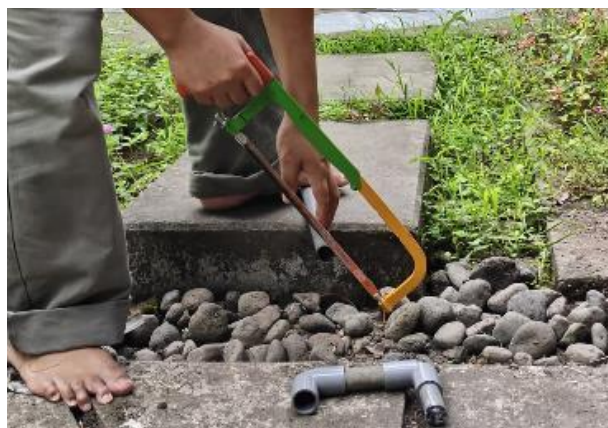
Gambar 9: Proses Pemotongan Pipa PVC Sebagai Jalur Aliran Disinfektan
