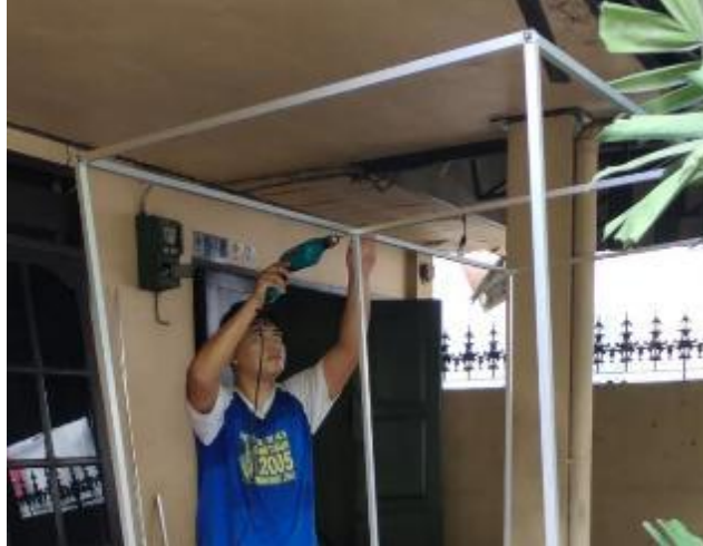
Gambar 7: Proses Perakitan Rangka Alumunium Hingga Membentuk Bilik
