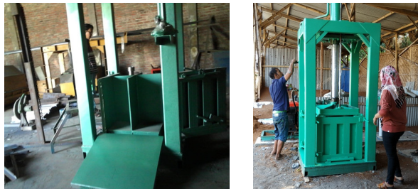
Gambar 3. Proses Pembuatan Mesin Peras
