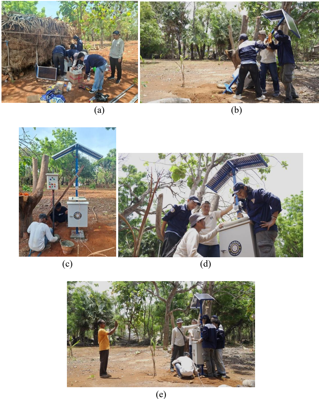
Gambar 6. Pembangunan fisik solar shelter
